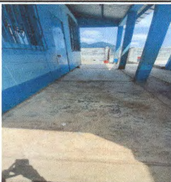
Foto 3: Sustitución de piso cerámico en el corredor
