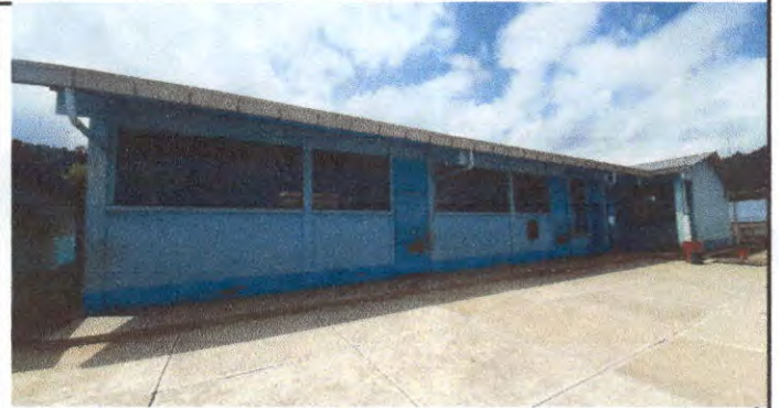
Foto 8: Pintado de pared de 3 aulas por afuera
