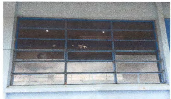
Foto 12: Fabricación e instalación de balcones de hierro en ventanas. 11 balcones
