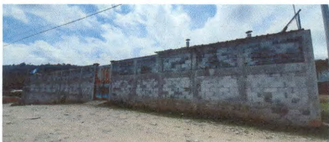
Foto 5: Pintado de muro exterior de frente
