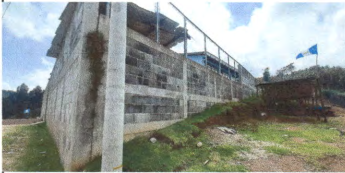
Foto7: Pintado del muro exterior lado derecho
