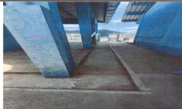
Foto 4: Sustitución de piso cerámico en el corredor
