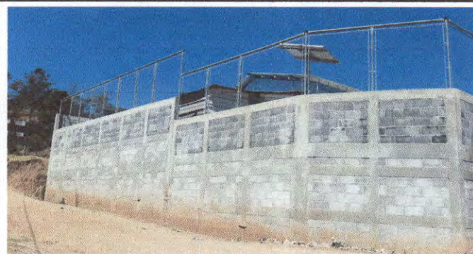
Foto 6: Pintado de muro exterior lado izquierdo
