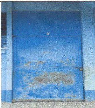
Foto 1: Pintado de puertas de aulas. 5 puertas
