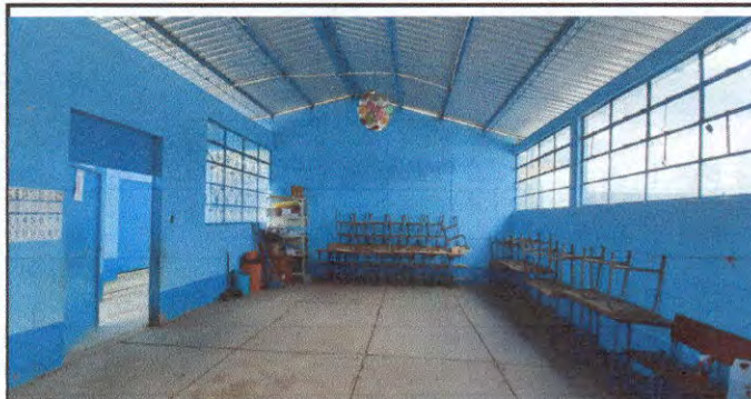
Foto 2: Sustitución de piso cerámico dentro del aula
