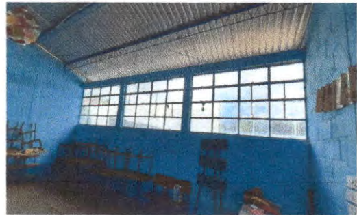
Foto 10: Pintado de pared de 3 aulas por adentro
